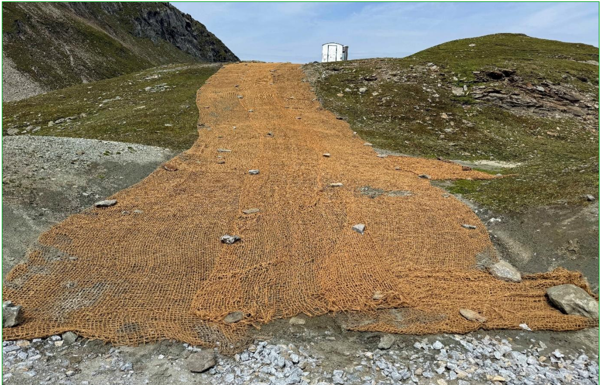
Bild 13: Diese Weganlage, die vor mehreren Jahren zu einer Wetterstation errichtet wurde, wurde im Zuge der Maßnahmen an der Rettenwandkompression ebenfalls begrünt (27.08.2025).
