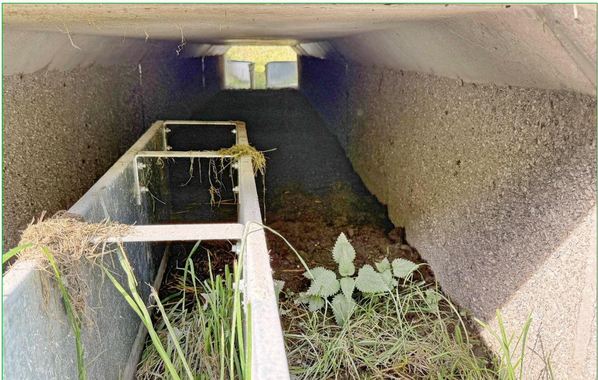
Bild 30: Die Erdpassage in den Tunneln ist durch die angelegten Retentionsbereiche durchgehend feucht (Pflanzenwuchs!) und ermöglicht so allen Tieren in allen Altersklassen ein Unterwandern der Straße (10.10.2025).
