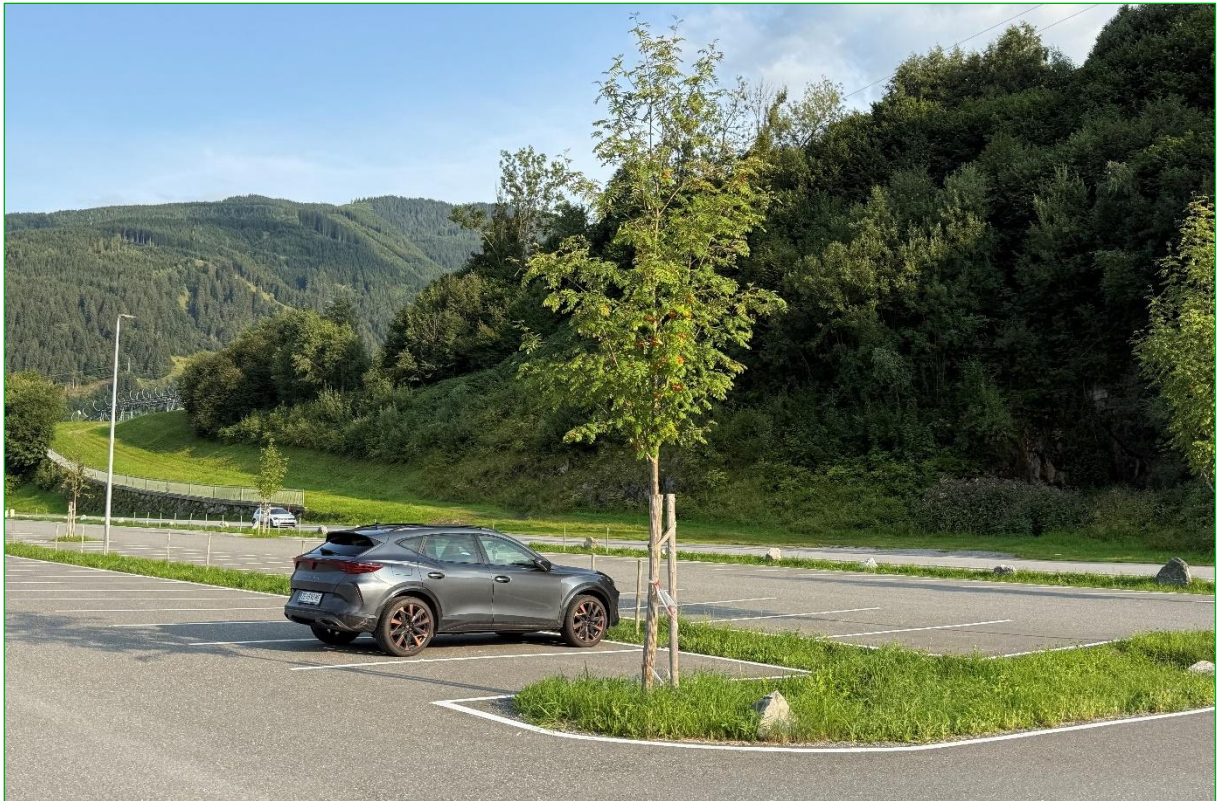
Bild 45: Der Parkplatz ist äußerst sauber, die für die Parkflächenentwässerung angelegten Sickermulden sind gut begrünt und erosionsfrei (06.08.2025).
