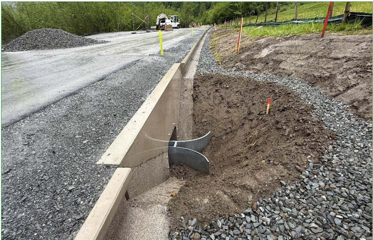
Bild 26: Retentionsbereich zur Feuchtigkeitsversorgung im Bereich der Tunnelsohlen und bereits eingebrachtes Einweiserblech, das die wandernden Amphibien auf die andere Straßenseite leitet (22.05.2025).
