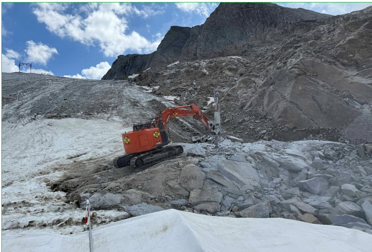
Bild 37: In diesem Bereich wurden die Arbeiten an der Verlegung der Schneileitung gestoppt, da die Eismächtigkeit noch zu groß ist, um die Verlegung zu ermöglichen (23.07.2025).
