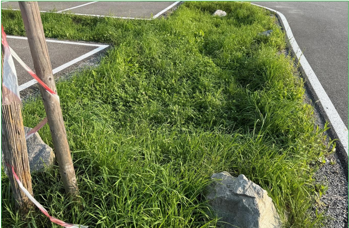
Bild 47: Detail aus den projektgemäß ausgeführten Sickersmulden im Bereich der Parkflächen (06.08.2025).
