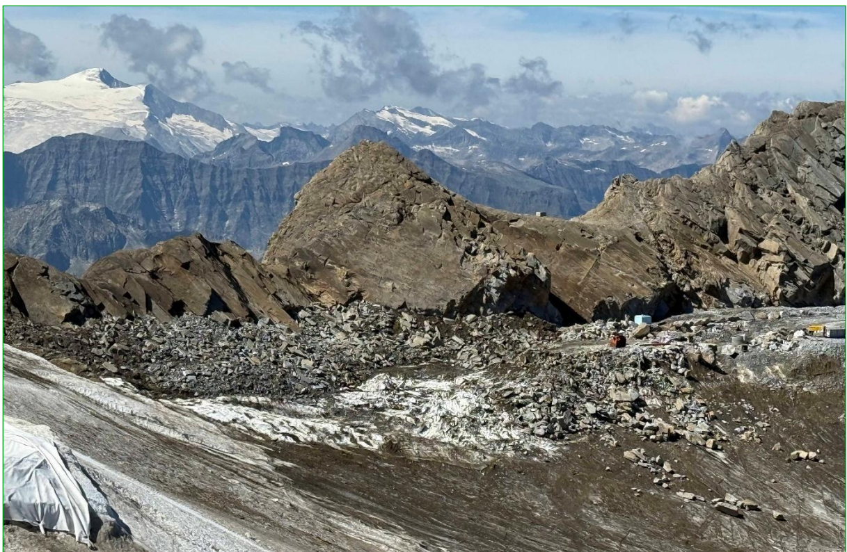
Bild 34: Durch der Natur angepasste Schüttungen wird versucht, die horizontale Linie der Schneileitungsverlegung landschaftlich nicht in Erscheinung treten zu lassen (19.08.2025).
