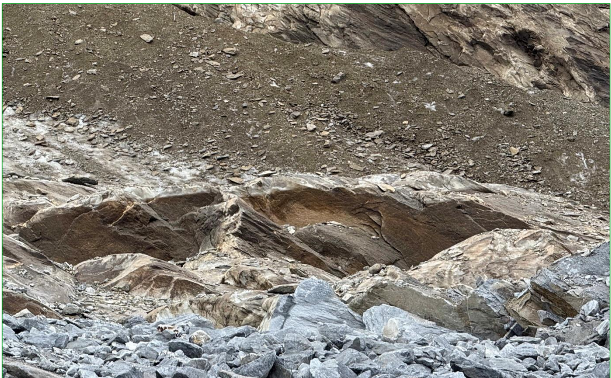
Bild 20: Geschüttete felsige Pistenbereiche im Vordergrund mit dem natürlichen Schutt des Gletschervorfeldes im Hintergrund (24.09.2025).
