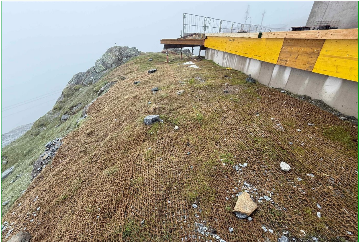
Bild 49: Überall dort, wo beim Umbau der Gletschermühle in Vegetation eingriffen wurde, wurde diese sofort wieder hergestellt und mit Kokosgewebe gesichert (16.07.2025).
