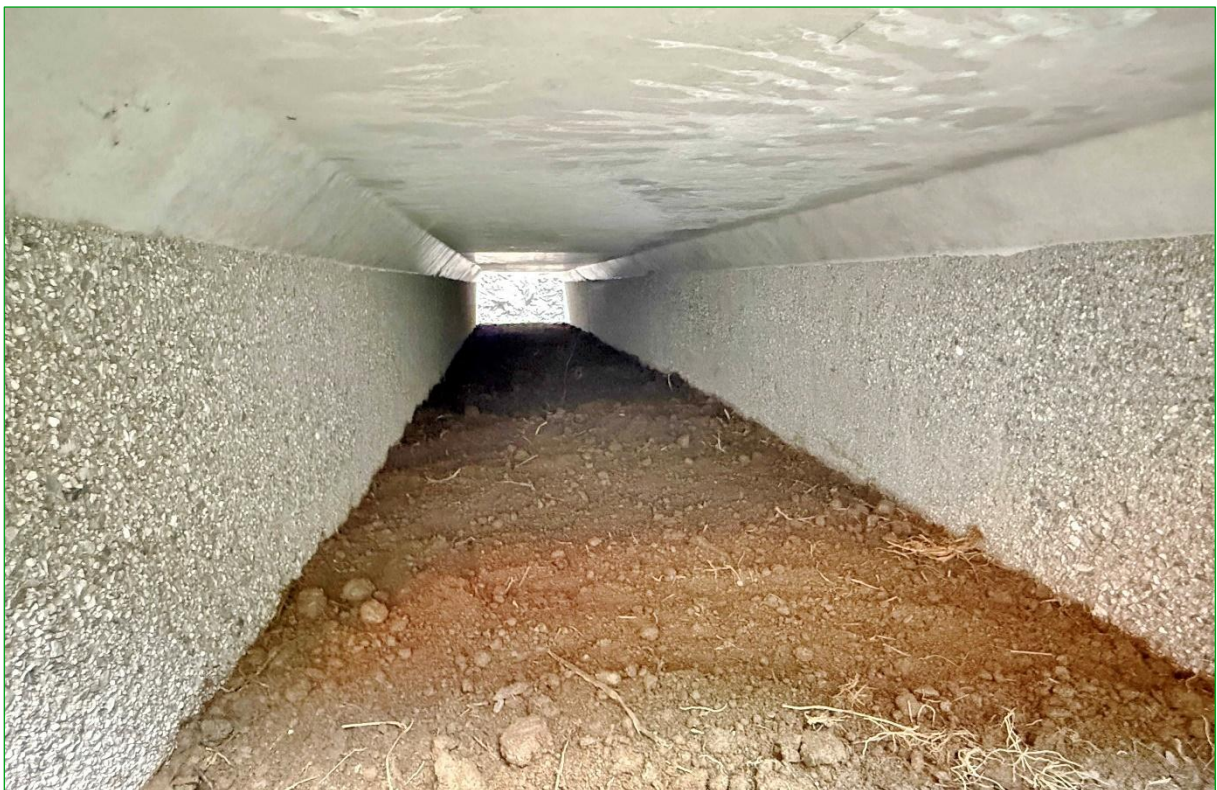
Bild 24: Optimal gestalteter Amphibientunnel („Krötendurchlass“) mit feuchter Laufsohle und aus Waschbeton gefertigten Seitenwänden (11.03.2025).
