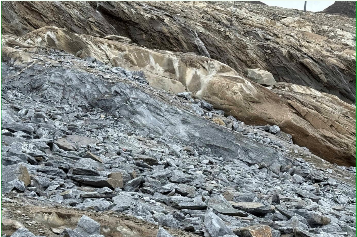
Bild 19: Auch die Sprengung der Felsriegel erfolgte schonend und in einer der Natur angepassten Form, so dass die natürlichen Strukturen (oberes Bilddrittel) von den hergestellten Strukturen (Bildmitte) nur in geringem Ausmaß zu unterscheiden sind (24.09.2025).
