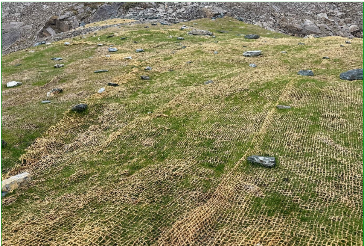
Bild 10: Das eingebrachte Saatgut beginnt bereits durch die Kokosmatten zu wachsen (24.09.2025).
