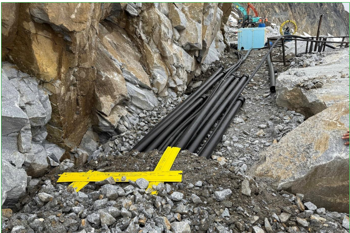
Bild 32: Die Leitungsverlegung erfolgt in einer aus dem kompakten Fels ausgesprengten Künette (06.08.2025).
