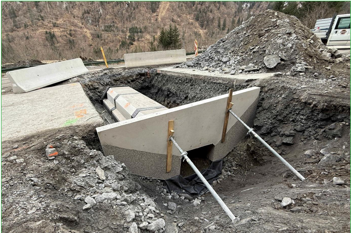
Bild 23: Als Ausgleichsmaßnahme für die Pistenanpassungen aufgrund des klimabedingten Gletscherrückganges wurde der Gletscherbahnen Kaprun AG die teilweise Errichtung einer Amphibienschutzanlage im Kapruner Tal vorgeschrieben (11.03.2025).
