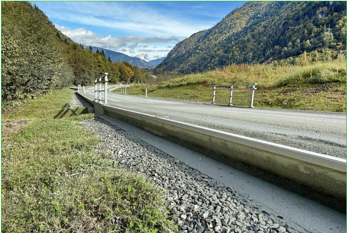
Bild 27: Fertig gestellte Tunnel-Leit-Anlage, die verhindert, dass Tiere auf die Straße gelangen, und andererseits wandernde Tiere unterhalb der Straße hindurchführt (10.10.2025).
