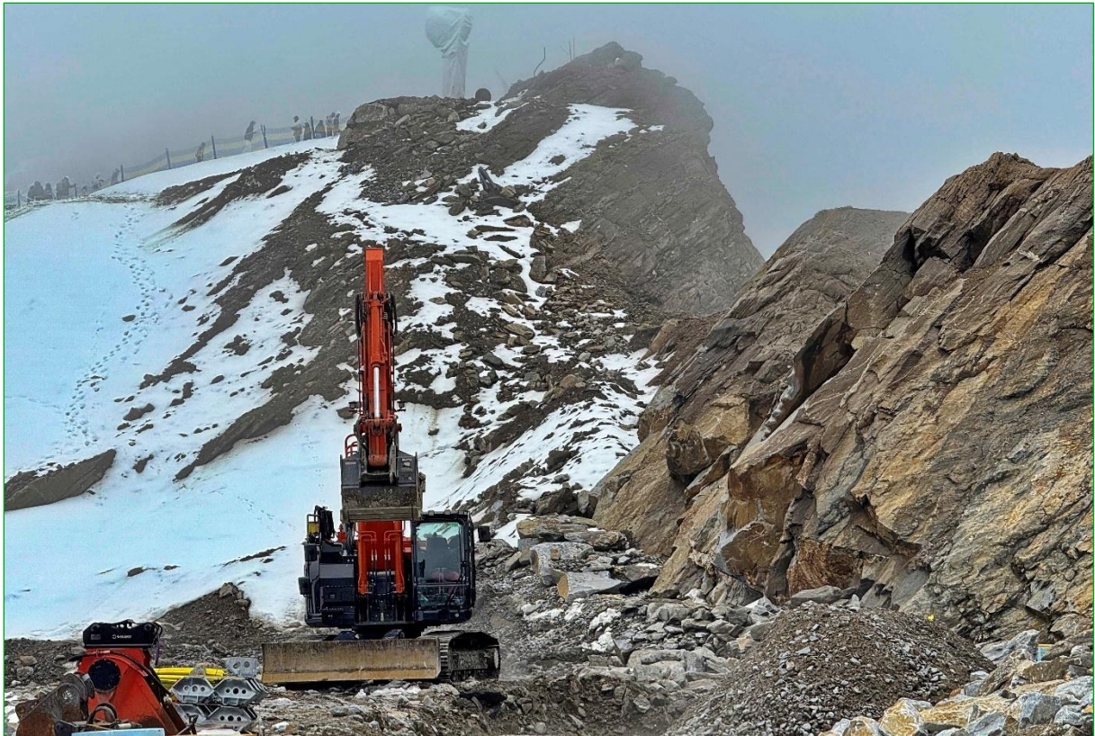
Bild 33: Bereits im Vorjahr naturnah überschüttete Künettenbereiche, die als solche nicht oder kaum mehr erkennbar sind (hinter dem roten Bagger, 06.08.2025).
