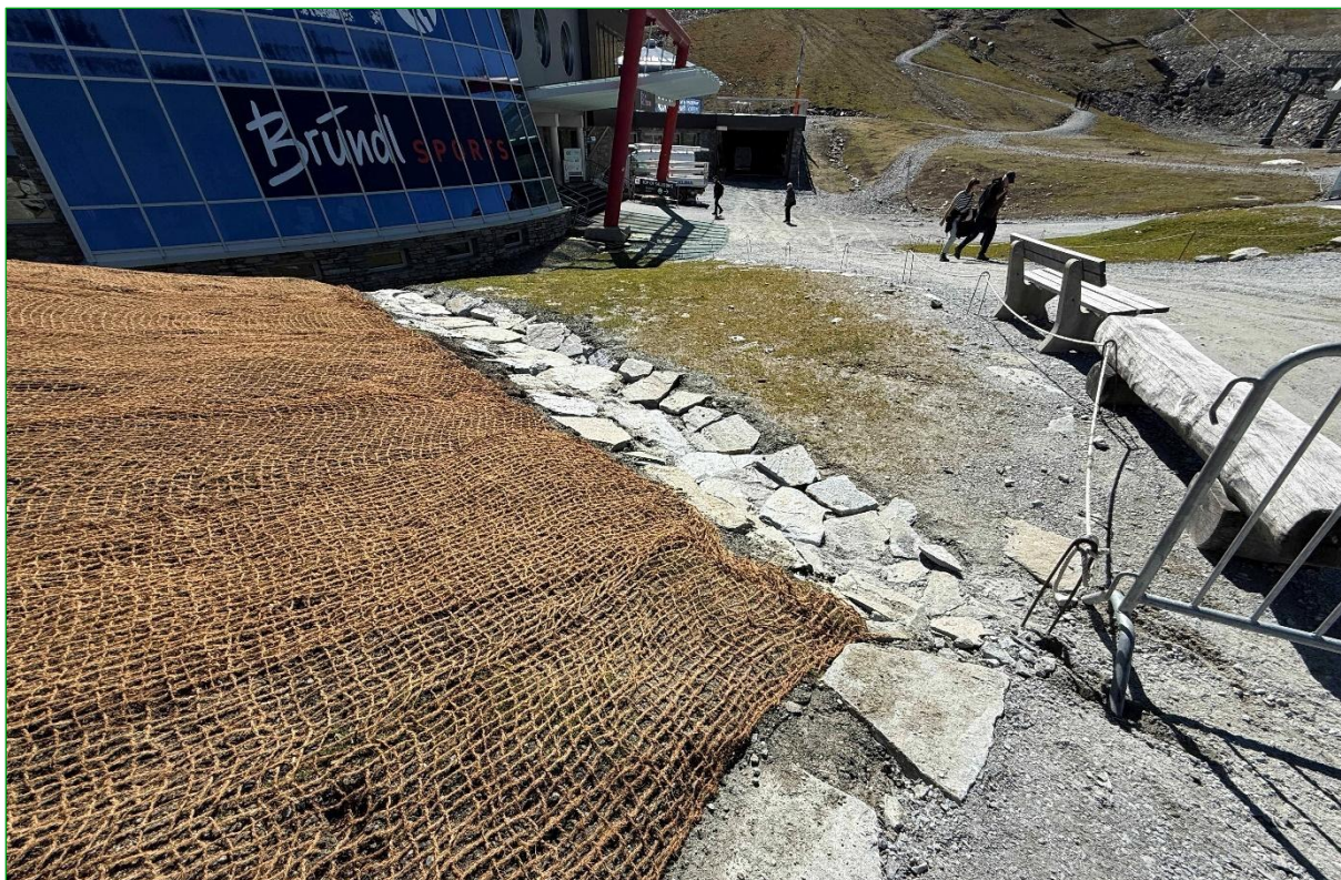
Bild 53: Im Zuge der neuen Begrünungsmaßnahmen zwischen Gletschermühle und Alpincenter wurde die Entwässerung durch diese mit Platten ausgelegte Rinne optimiert (18.09.2025).
