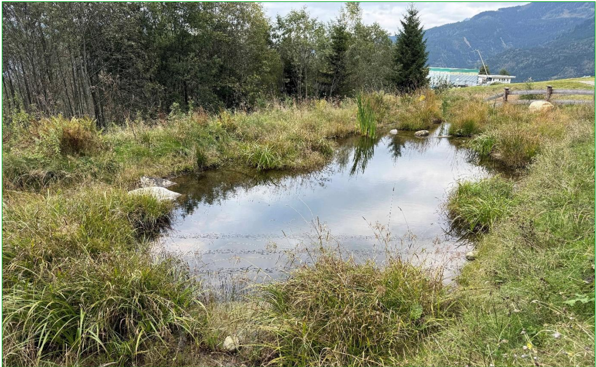
Bild 43: Durch eine entsprechende Konstruktion kann der Hauptteil des Ausgleichsgewässers für den Maislift II nicht verlanden, die offene Wasserfläche bleibt dauerhaft erhalten (02.10.2025).
