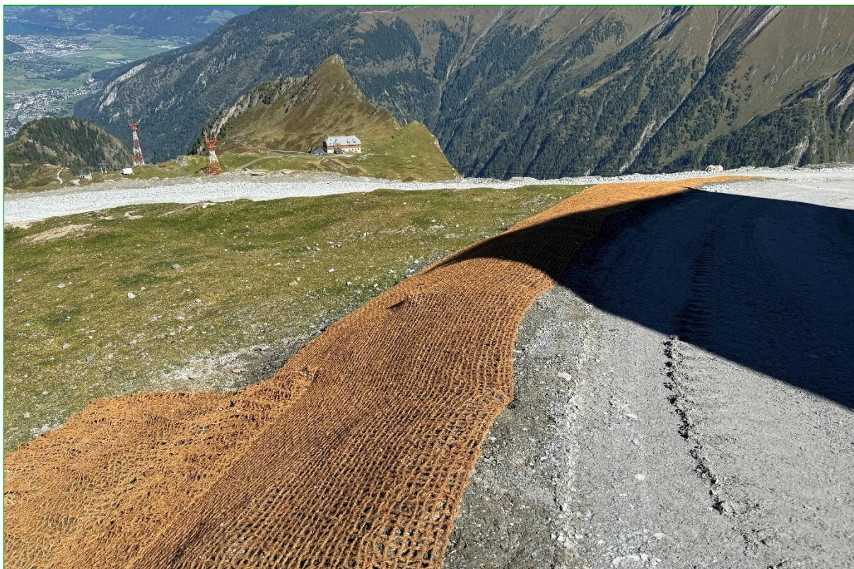
Bild 54: Im Zuge des Bauvorhabens an der Gletschermühle beeinträchtigte Wegböschungen wurden umgehend saniert und fachgerecht begrünt (18.09.2025).
