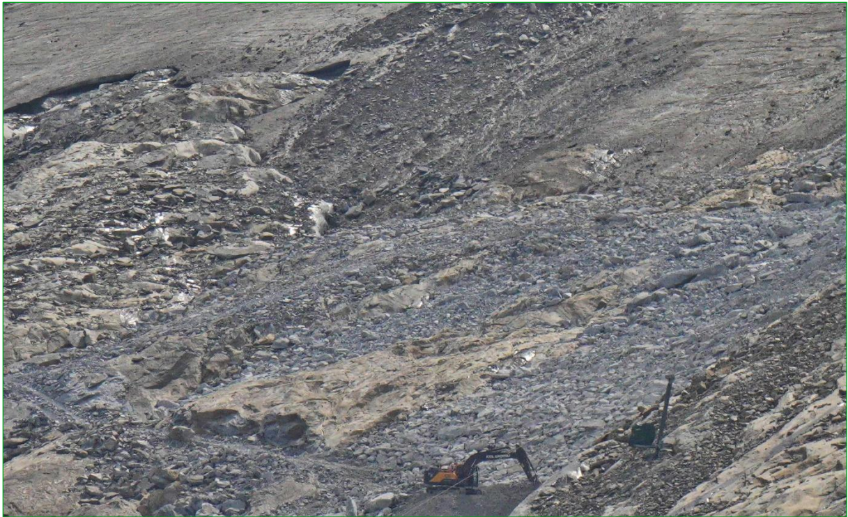
Bild 15: Die Gestaltungsmaßnahmen in den Gletscherrandbereichen erhalten relativ ebene gletschergeschliffene Felsflächen und füllen durch abgesprengtes Material die dazwischen liegenden Senken mit naturnaher Strukturierung auf. Nach dem natürlichen Abdunkeln des frisch gebrochenen Felsmaterials (untere Bildhälfte) wird kaum mehr ein Unterschied zur Naturlandschaft (obere Bildhälfte) gegeben sein (27.08.2025).
