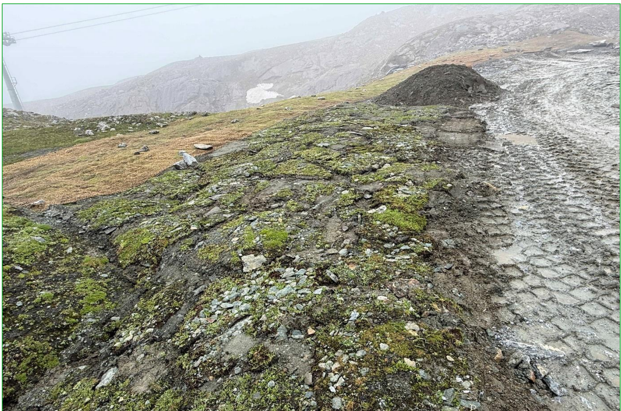
Bild 8: Zwischengelagerte Vegetation für die Anwendung des Saat-Soden-Kombinationsverfahrens im Bereich der Begrünung der Geländeanpassung der Rettenwandkompression (28.07.2025).
