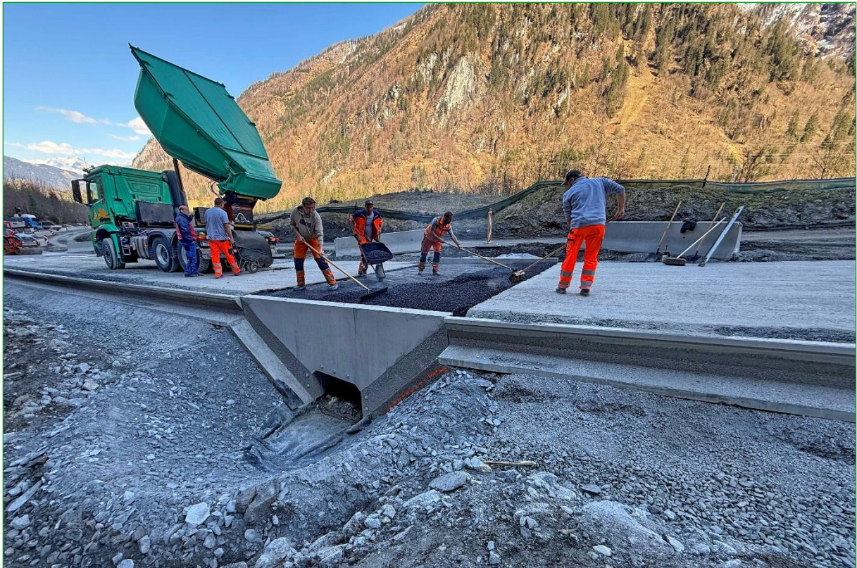
Bild 25: Fertig eingebauter Tunneldurchlass mit beidseitigen Sperrelementen beim Wiederherstellen der Straßenverbindung (03.04.2025).
