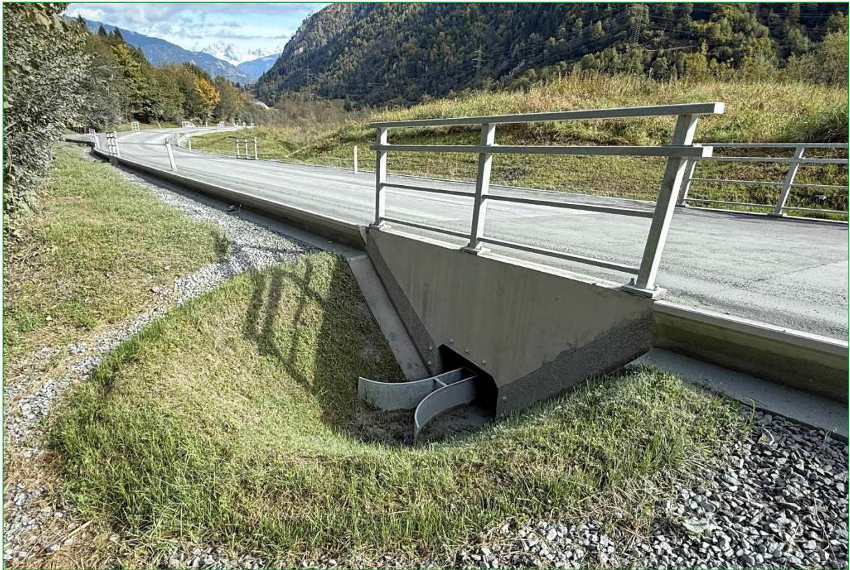
Bild 29: Fertig gestellte und bereits einmal ausgemähte Tunnel-Leit-Anlage mit Retentionstrichter, Einweiserblech, Tunneldurchgang und Sperrelementen an der Straße (10.10.2025).
