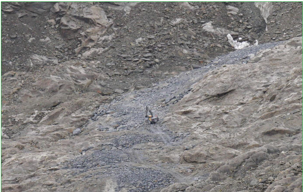
Bild 16: Bagger beim Gestalten der Gletscherseepiste ebenfalls durch Auffüllen von Geländesenken mit Felsmaterial unter Erhaltung der Felsbuckellandschaft im Gletschervorfeld (24.09.2025).
