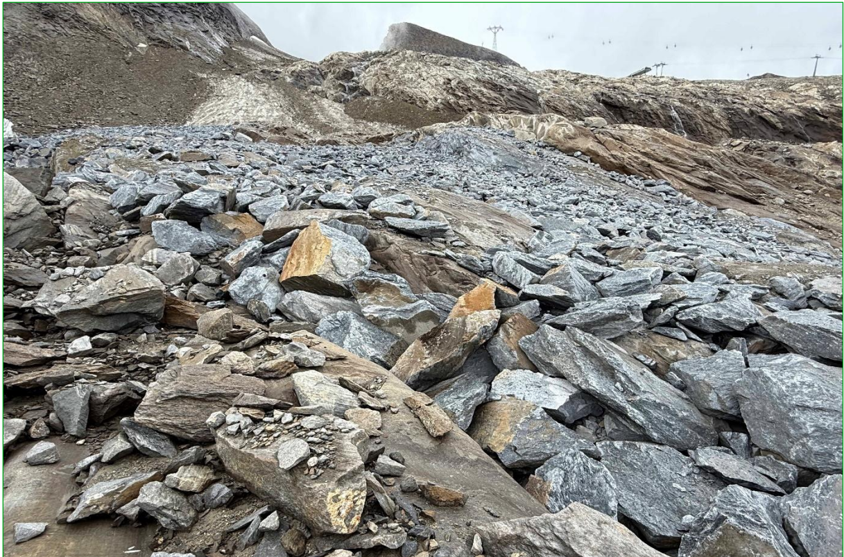
Bild 17: Das frisch gebrochene Felsmaterial weist derzeit noch eine relativ auffällig hellgraue Farbe auf, diese wird sich jedoch im Zuge von Verwitterungsvorgängen dem natürlichen Umfeld angleichen (24.09.2025).
