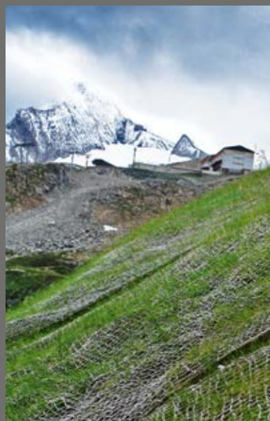
Die per Hand fixierte Kokosmatte verhindert die Ausschwemmung und unterstützt das Anwachsen der Pflanzenkeime.
