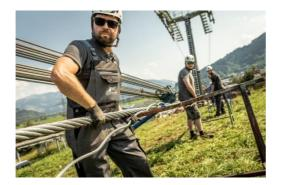
Das Seilspleißen, eine anspruchsvolle Tätigkeit, bei der händisch, die beiden Seilenden zu einer Schlaufe verbunden werden.
